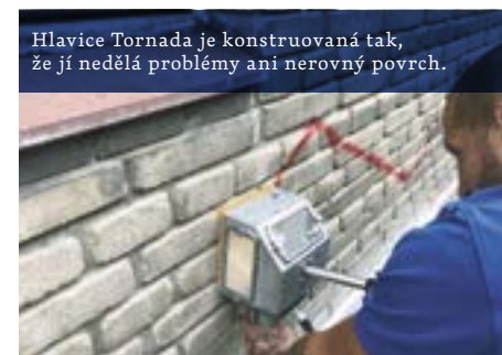
Průběh práce obsluha Tornada sleduje prostřednictvím tří rozměrných okének na pracovní hlavici.
