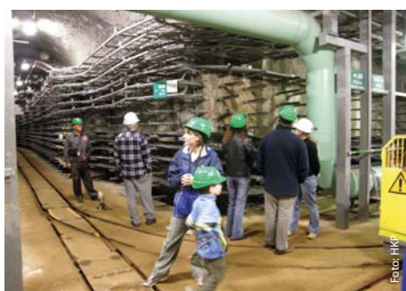
Prohlídka kolektorů – zážitek, který jinde než v Praze neprožijete.
