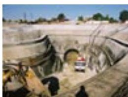
Srpen 2004, zahájení ražby přístupové štoly
