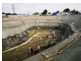
Červenec 2004, hloubení jámy pro sjezdovou rampu
