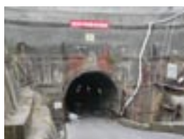
Listopad 2006, poslední okamžiky před zabetonováním
